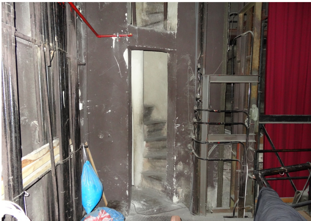
3047 zabezpieczenie wejść z pomostów technicznych sceny do klatek schodowych K-6 i K-7 urządzeniami instalacji zraszaczowej.
