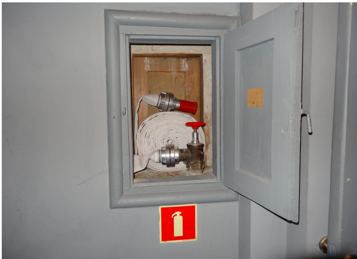
3041 przeciwpożarowy hydrant wewnętrzny dwustronnie obsługiwany zamontowany w ścianie oddzielenia przeciwpożarowego scena/korytarz ewakuacyjny.
