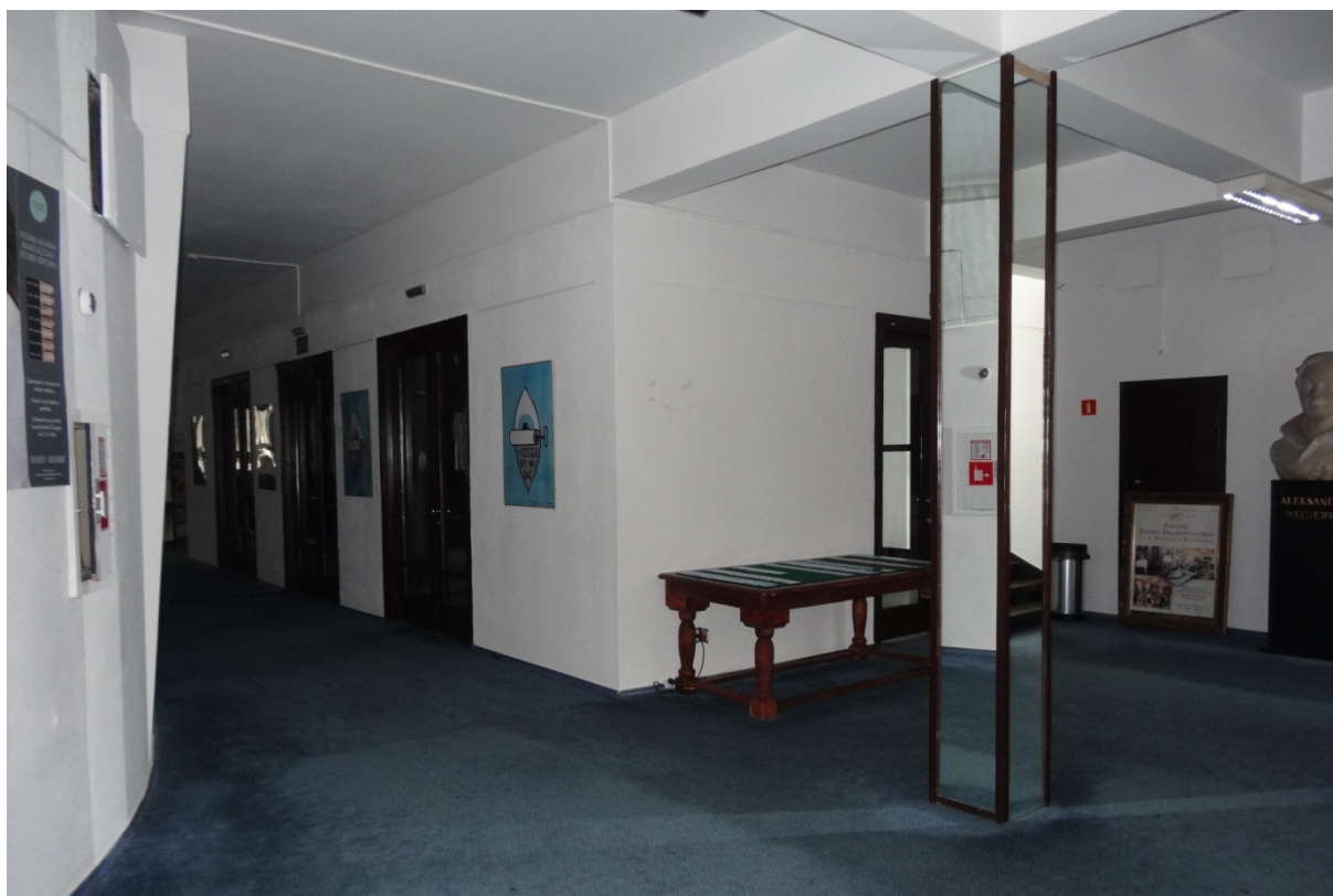
2943 drzwi do holu wejściowego prowadzące z holu prawego i lewego (3 szt.). Po prawej stronie widoczna część drzwi do holu wejściowego z klatek schodowych K-1 i K-2. U góry podciąg przy którym zastosowane zostaną ruchome kurtyny dymowe DH 60. Korytarz łączy hol prawy z lewym z klatkami schodowymi K-1 i K-2.
