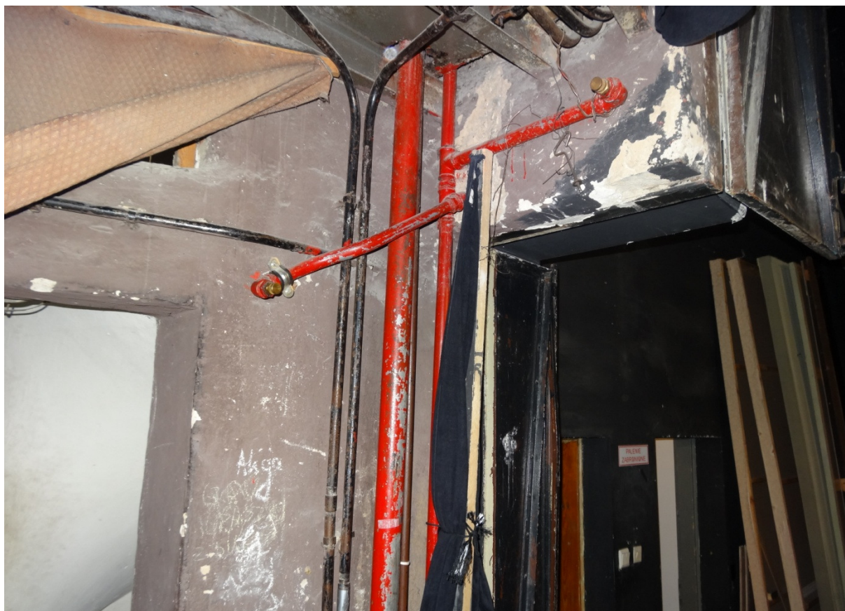
3045 zabezpieczenie otworu drzwiowego sceny urządzeniami zraszaczowymi.
