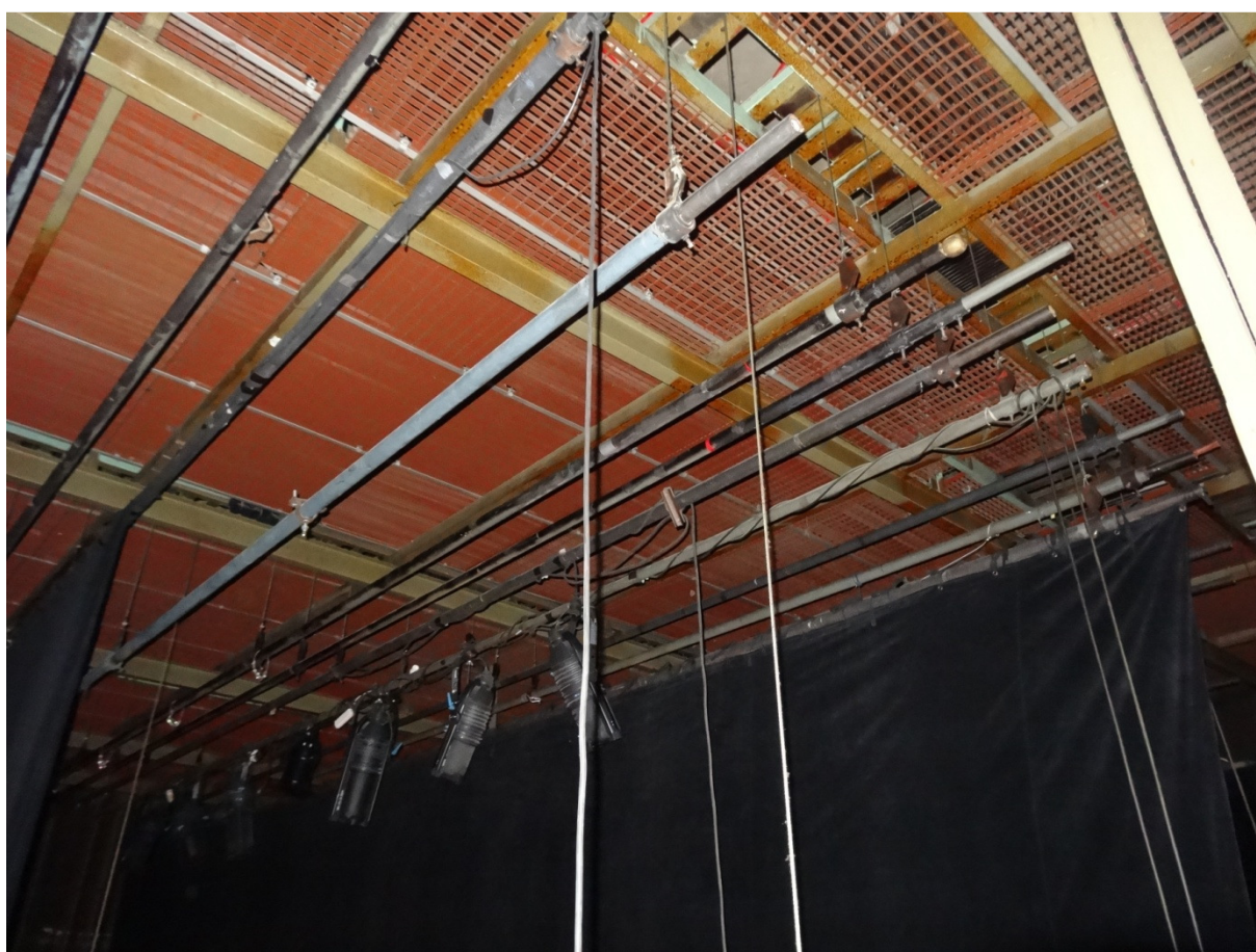
3049 elementy głównej konstrukcji stalowej pomostu technicznego nad sceną.
