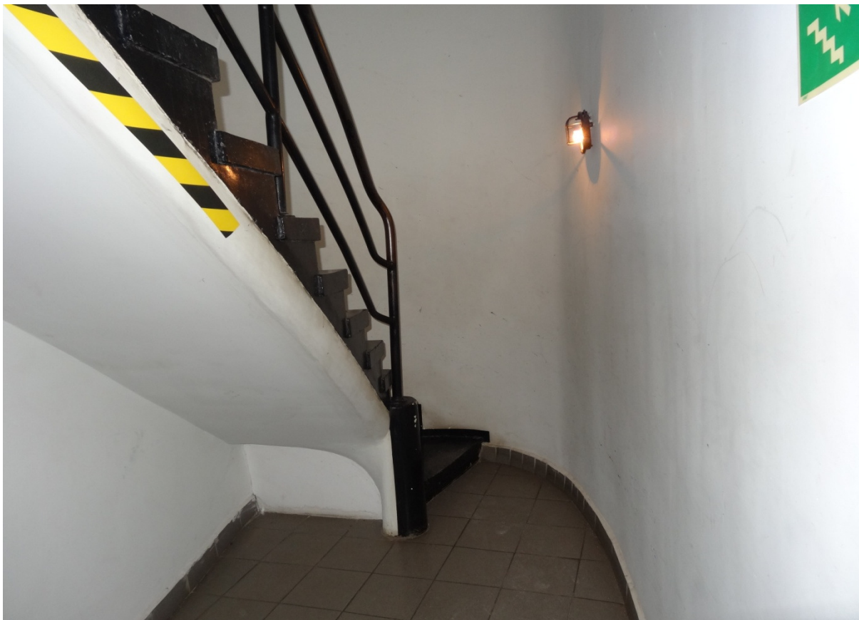
2915 klatka schodowa K-3 na kondygnacji 0 z oprawą oświetlenia ewakuacyjnego.
